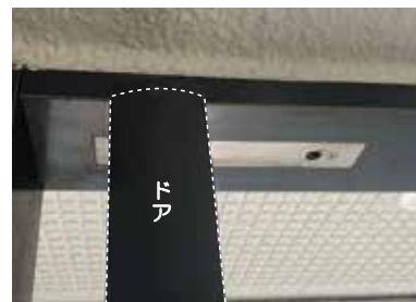
④トップピボット（上枠側）
